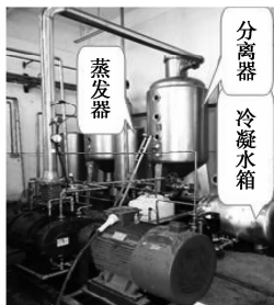
图2 MVR热泵中药蒸发浓缩系统
