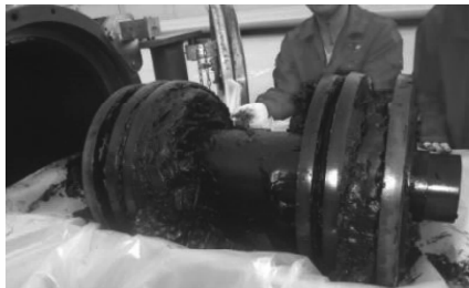
图 1 青县中间热泵站收到的清管器
