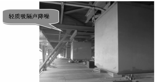
图 5 电机隔声罩实例图
