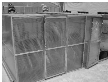
图 2 一级气浮池密封形式
