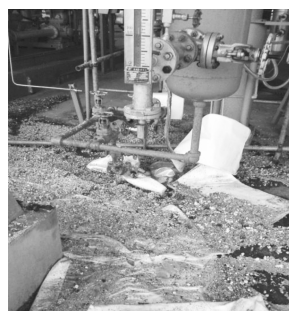
图 4 压缩机集液包聚合物
