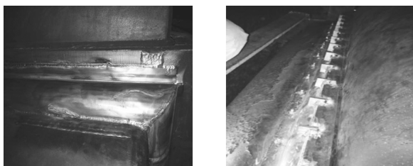
(a) 包边开裂处焊接修复
