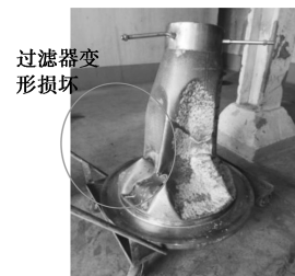
图 8 循环气压缩机二段入口过滤器
