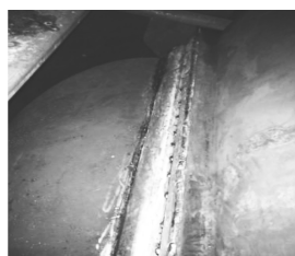
(c) 包边用 DN50 管剖加固
