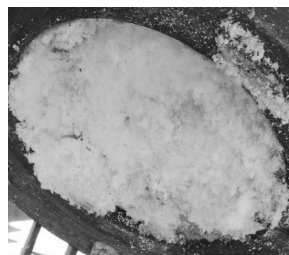
图 1 塔侧管道聚合物
