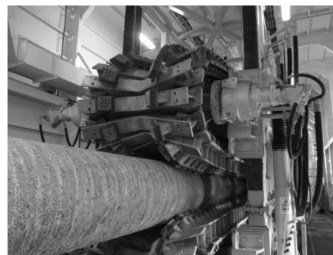
图 4 铺管船张紧器
